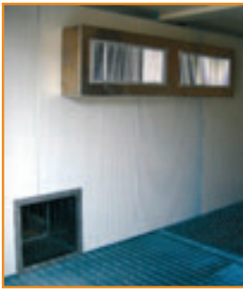
Grille de reprise d'air et grille de diffusion avec ailettes orientables
