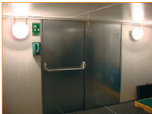
Barre anti-panique sur porte avec lave œil Autonome (voir page 36) - Luminaire Atex* type hublot
