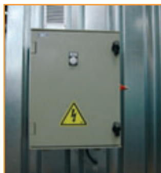
Coffret électrique pour maintien hors gel ou ventilation standard ou ATEX*
