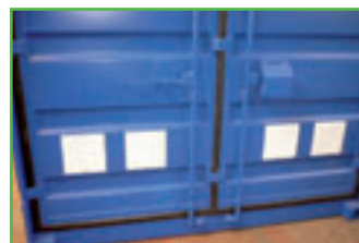
Grilles de ventilation sur portes
