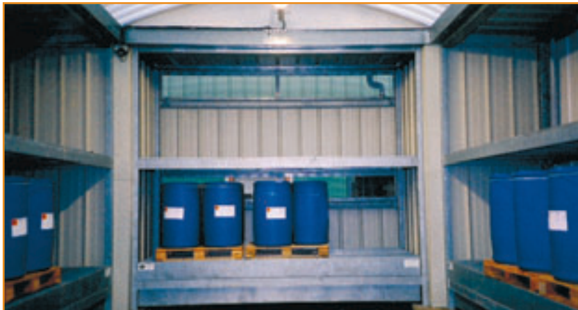
Vue intérieure avec grilles d'aération spéciales
